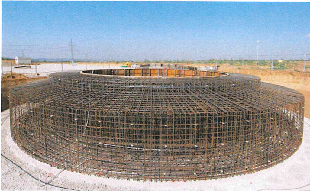
Fundamentarmierung für Windindustrieanlage Enercon E82 in Ingersheim Nabenhöhe nur 78 – 138 Meter
